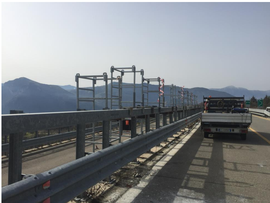
SERIE DI ELEMENTI - VISTA SUL PIANO STRADALE
