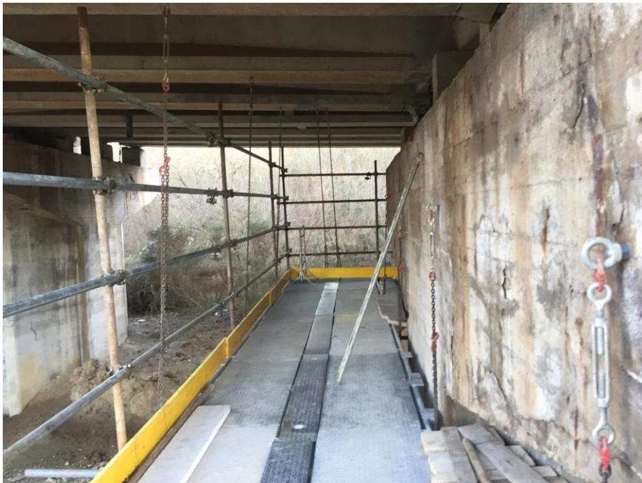
PIANO DI LAVORO PERIMETRALE AL PULVINO
