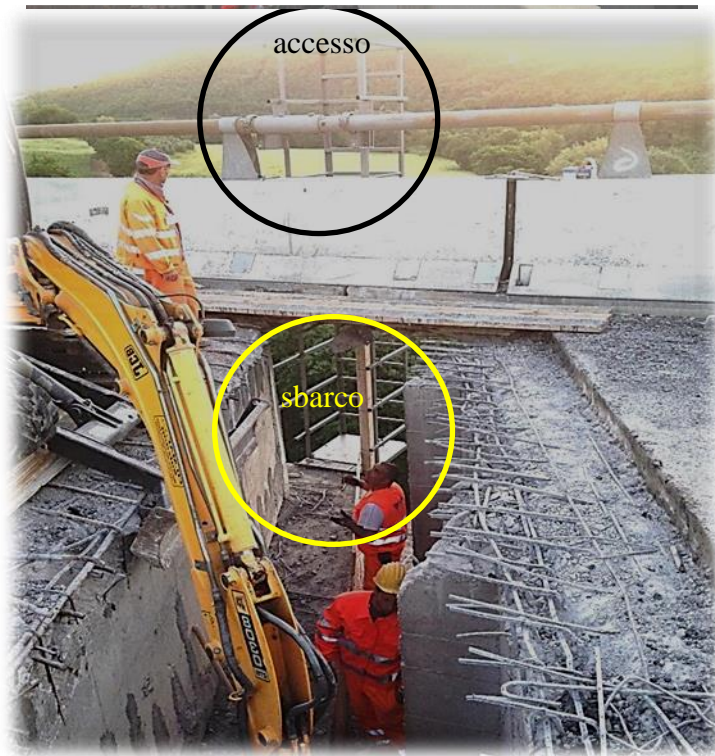
VISITA DALLA SEDE STRADALE – ASSENZA DI INTERFERENZA CON LA VIABILITA'
