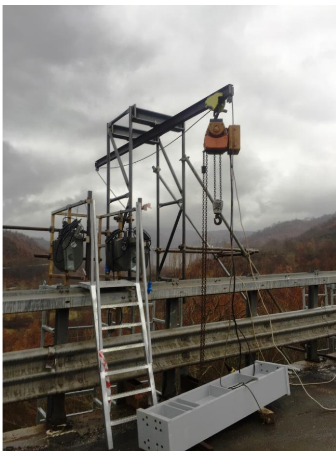
COMODA SCALA ACCESSO E TORRETTA DI CARICO CON PARANCO SCORREVOLE
