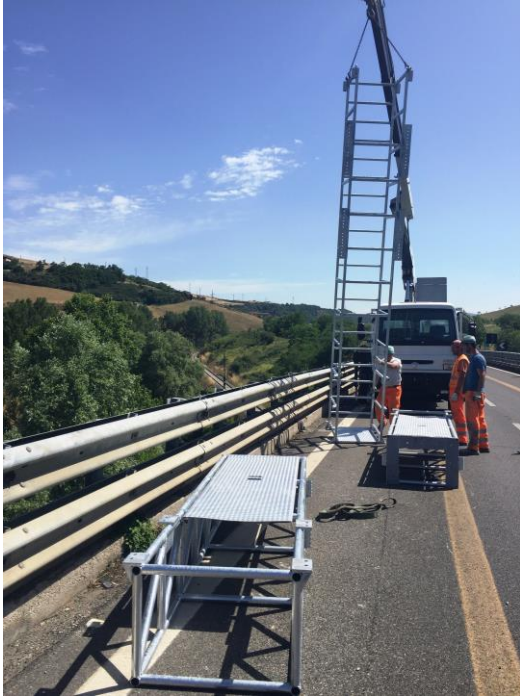
MONTAGGIO DEL TRALICCIO SCALA
