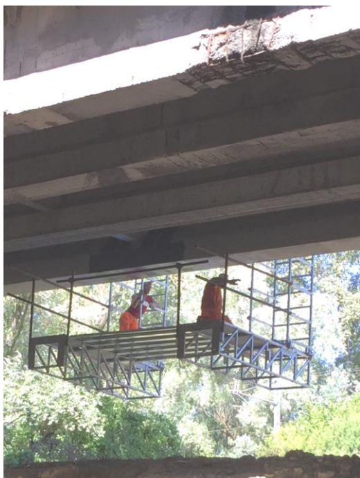
MONTAGGIO SECONDO ELEMENTO E COPERTURA DEL PIANO DI COLLEGAMENTO
